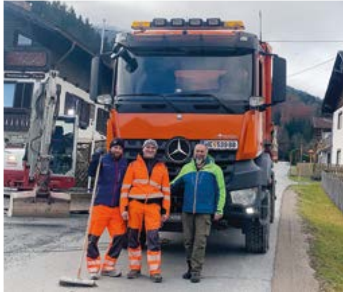
Sanierung Schlanitzer Straße
